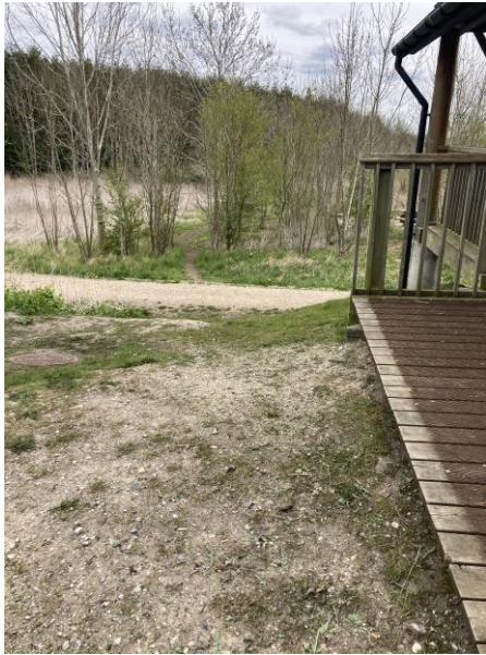
En trappe ned over den slidte skrånning savnes
